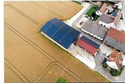
Erzeugt über 100.000 kWh sauberen Strom: Die PV-Anlage auf Matthias Kühnbachs Mehrzweckhalle
